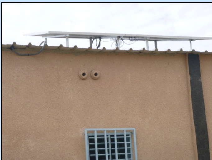
Panneaux solaires installés
